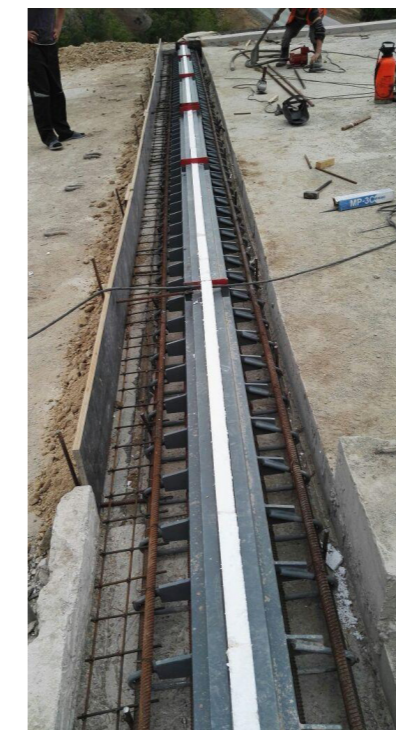
ДШ-Б для мостов с малой температурно-неразрывной плетью
