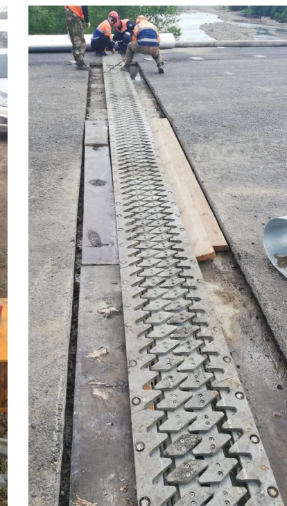
ДШ-ПТш с шумопоглощающей пластиной (снижает шумы и вибрации)
