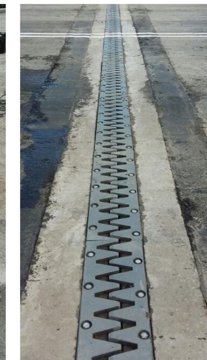
ДШ-Бш с шумопоглощающей пластиной (снижает шумы и вибрации)
